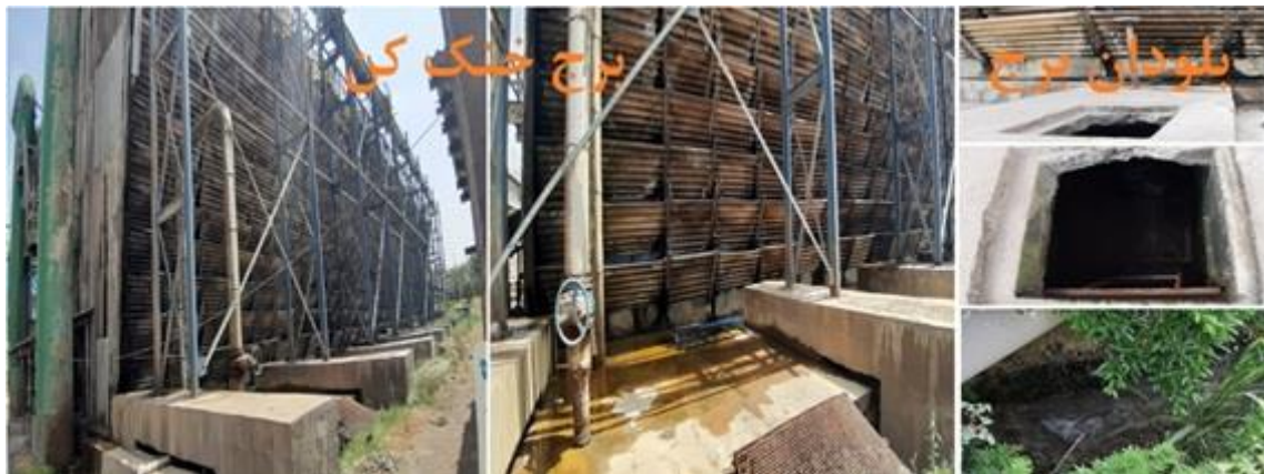
شکل ۱- تصویر برج خنک‌کننده تر جریان متقاطع و مسیر زیرکش خروجی نیروگاه لوشان
